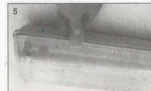
5. Montar los soportes de anclaje (H) la carcasa gris de la pantalla. Fijar el difusor transparente a la carcasa gris.
